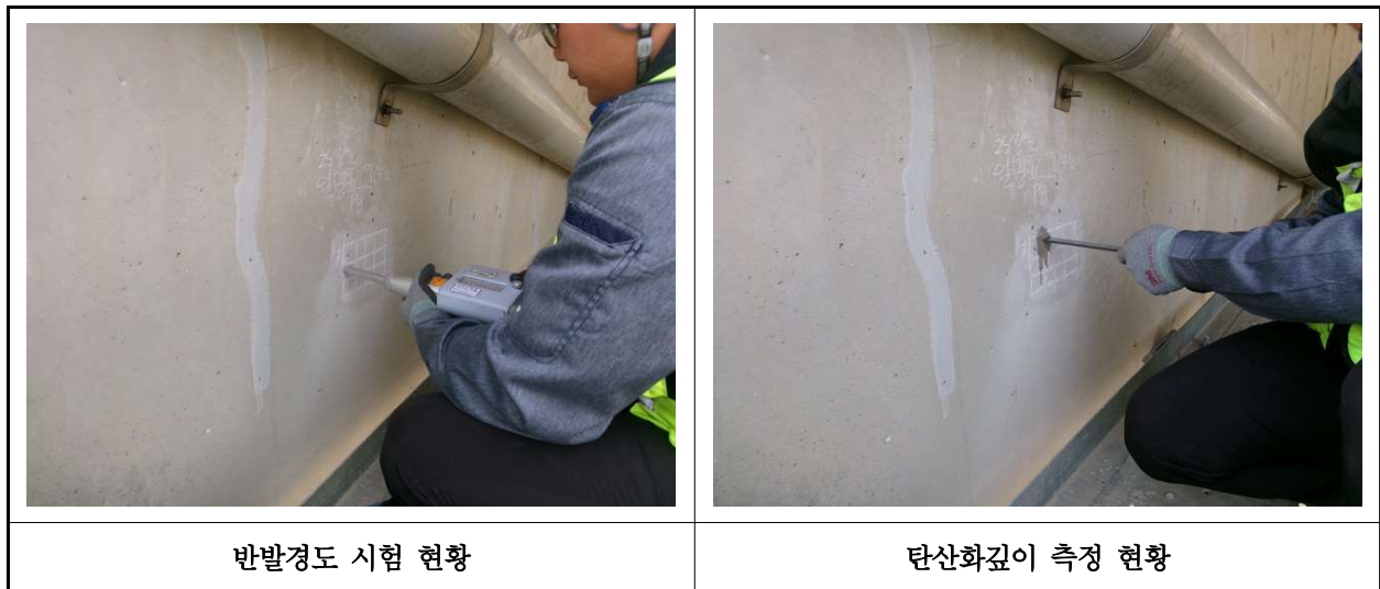
【사진 38.4.1】 콘크리트 내구성조사 현황
