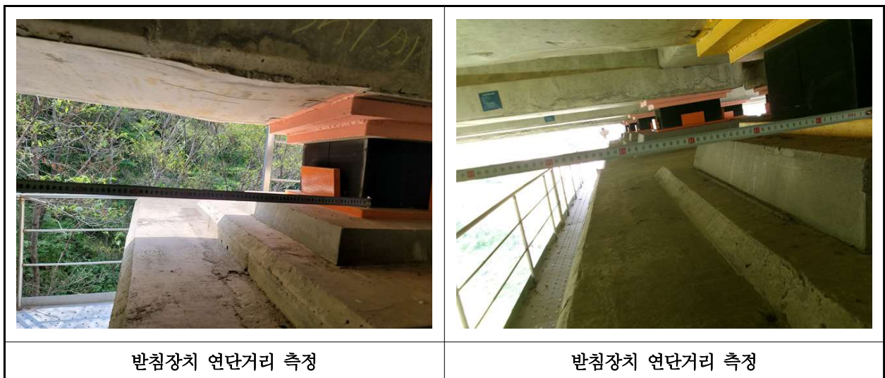
【사진 38.3.15】 교량받침장치 연단거리측정
