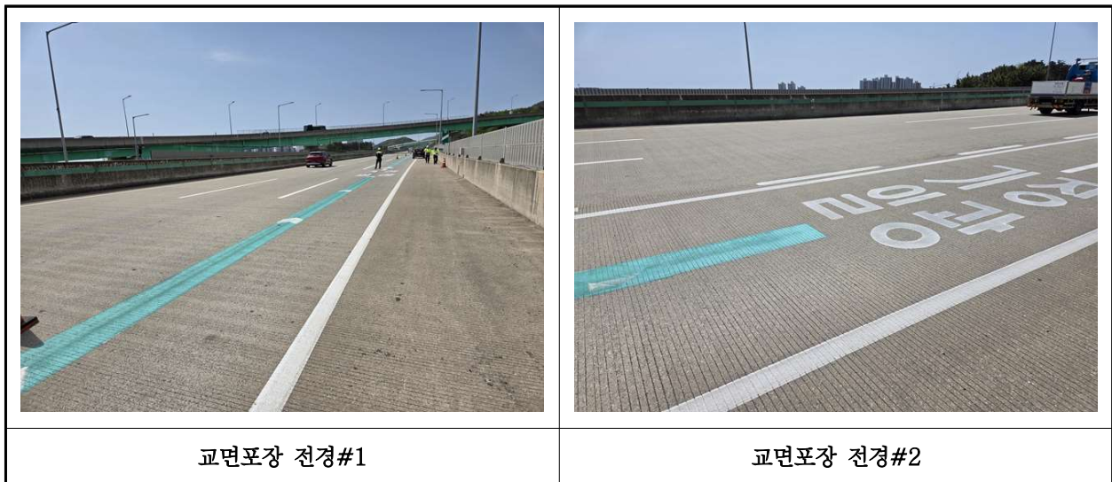
【사진 38.3.20】 교면포장 전경
