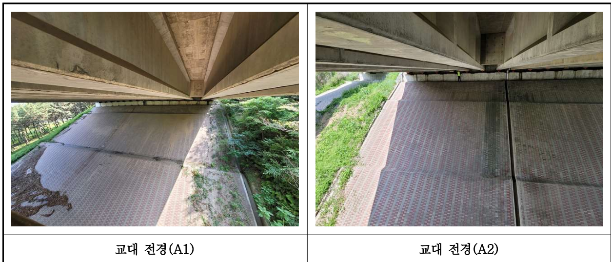
【사진 38.3.8】 교대 전경
