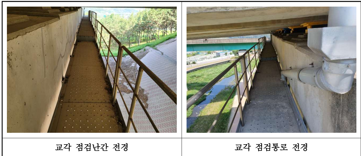
【사진 38.3.26】 교량 점검시설 전경
