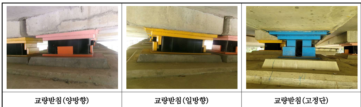
【사진 38.3.13】 교량받침 전경
