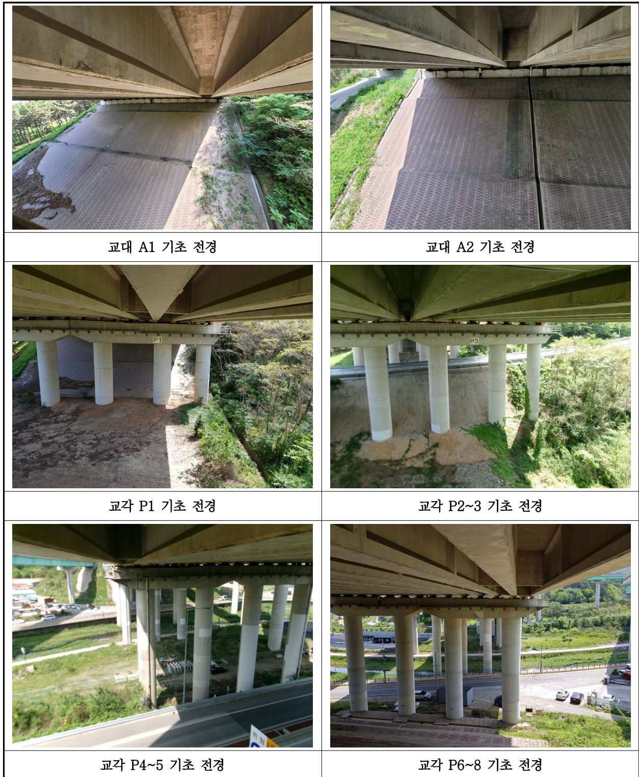
【사진 38.3.12】 기초 전경
