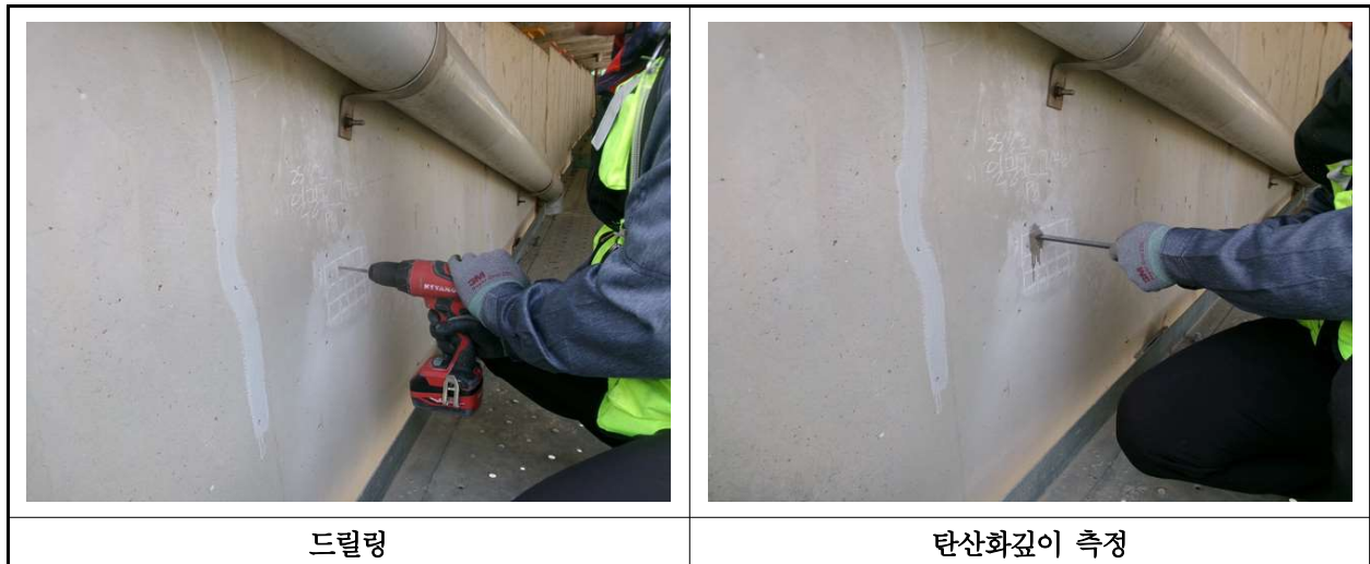
【사진 38.4.3】 탄산화 깊이 측정 현장사진
